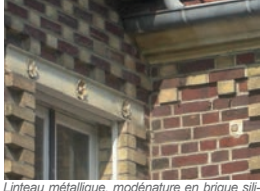
Linteau métallique, modénature en brique silico-calcaire et brique argile
