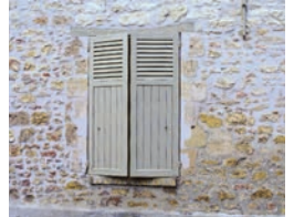
Maçonnerie moellon à pierre vue
