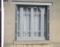
Baie avec linteau et volets métalliques pliants
