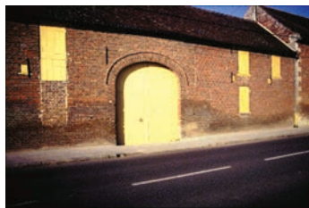
Grange avec porte charretière
