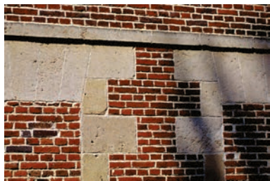
Mur de brique avec bandeau et encadrements en pierre de taille
