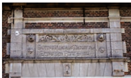
Porche en pierre ouvragée
