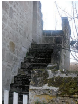
Escalier en pierre sur pignon
