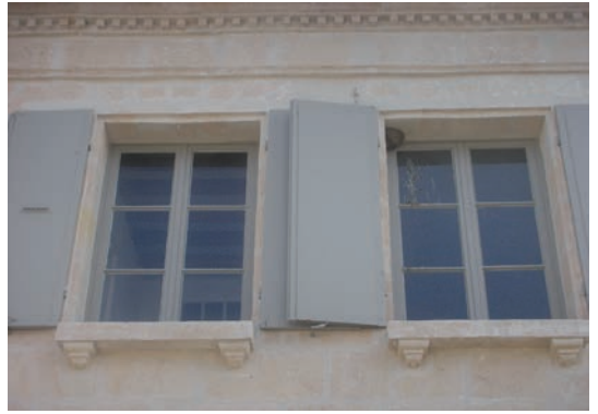
Corniche avec denticules, appuis de fenêtre et feuillure en pierre de taille avec joints à la chaux arasés au nu de la pierre
