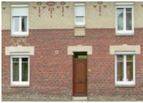
Mur en brique rouge et silico-calcaire
