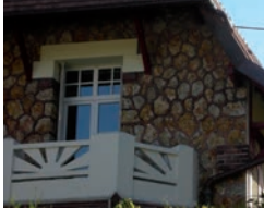
Balcon en béton d'une maison en meulière
