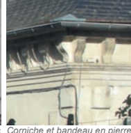
Corniche et bandeau en pierre
