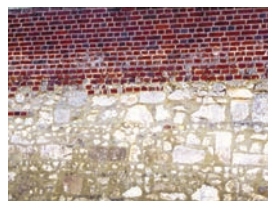
Brique et moellon calcaire
