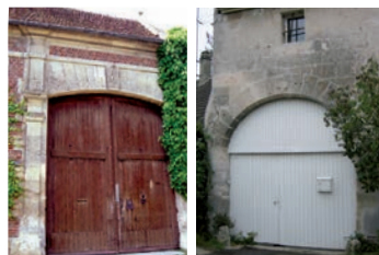
Porche d'entrée avec encadrement ouvragé en pierre
