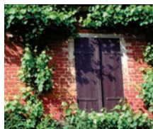
Brique recouverte d'un lait de chaux
