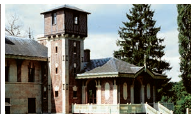
Réhabilitation de l'ancien pavillon de chasse de l'impératrice Eugénie à Vieux-Moulin
