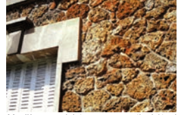
Meulière avec joint creux au mortier bâtard
