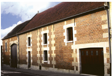
Réutilisation d'une grange en logement
