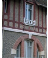
Façade en enduit mouchetés et faux pans de bois
