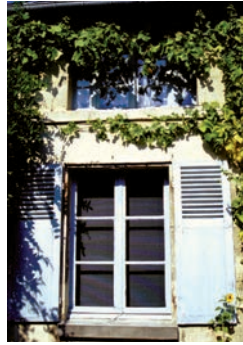
Mur appareillé en pierre, harpes en pierre de taille et remplissage en moellon lié au mortier de chaux
