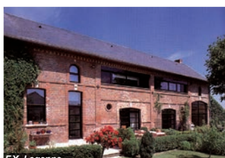
F.X. Legenne Rénovation d'une grange du XIX ème siècle en habitation conservant la volumétrie initiale et le parement brique
