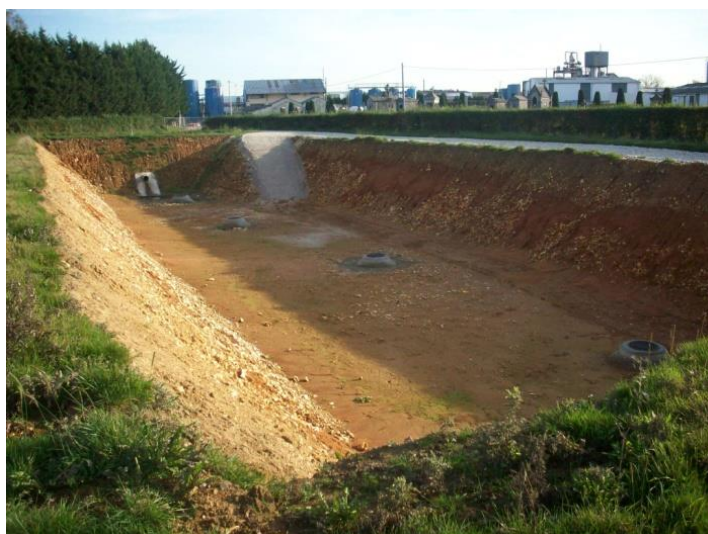
Figure 81. Exemple de bassin d'infiltration réalisé par Verdi Ingénierie Seine
