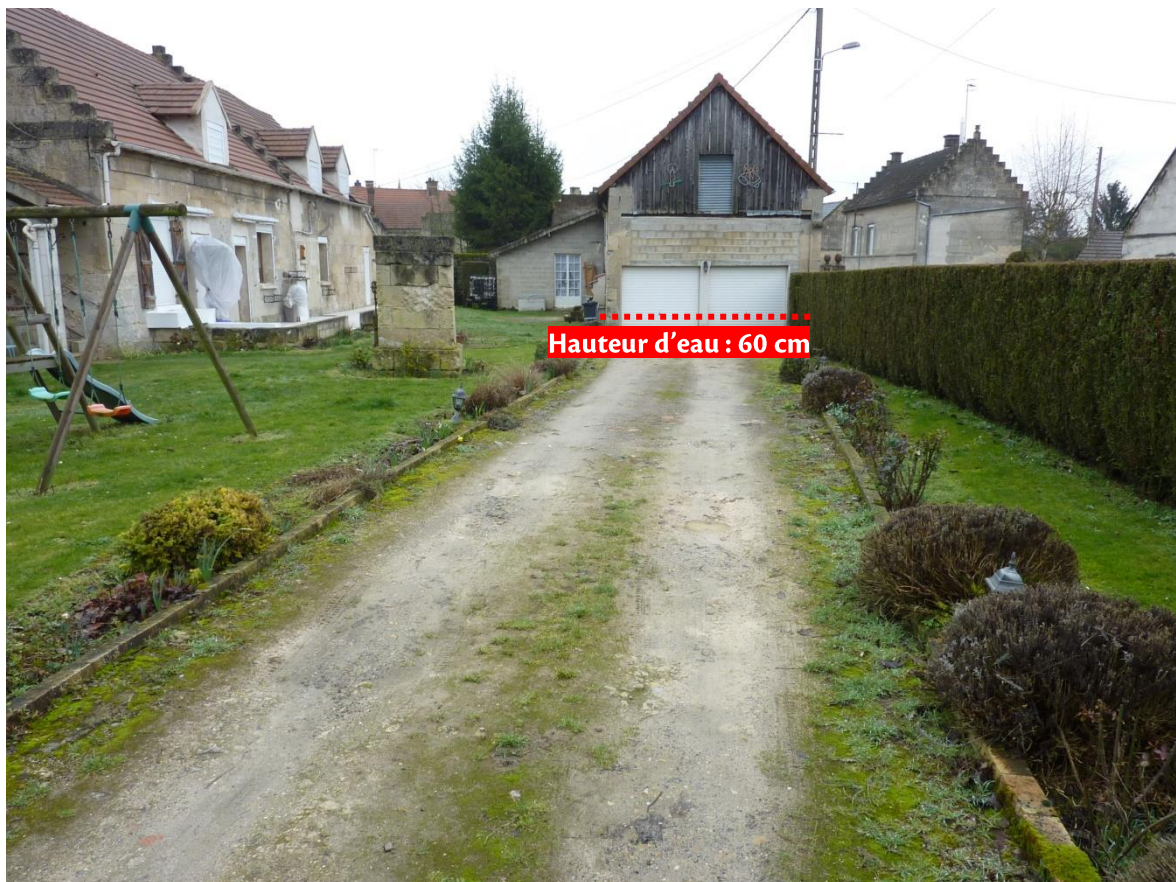
Figure 35. Photo du garage inondé
