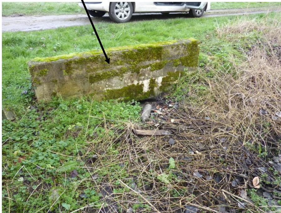
Figure 21. Localisation de l'exutoire bouché et de l'habitation en zone inondable dans la rue Paillet
