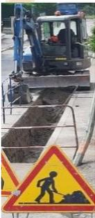
Comme vous l'avez sûrement constaté, Enedis effectue des travaux dans notre commune : il s'agit d'enfouir la ligne électrique haute tension de 20 Kvolts afin d'éviter les risques de coupure électrique car la ligne haute tension est en fin de vie.
