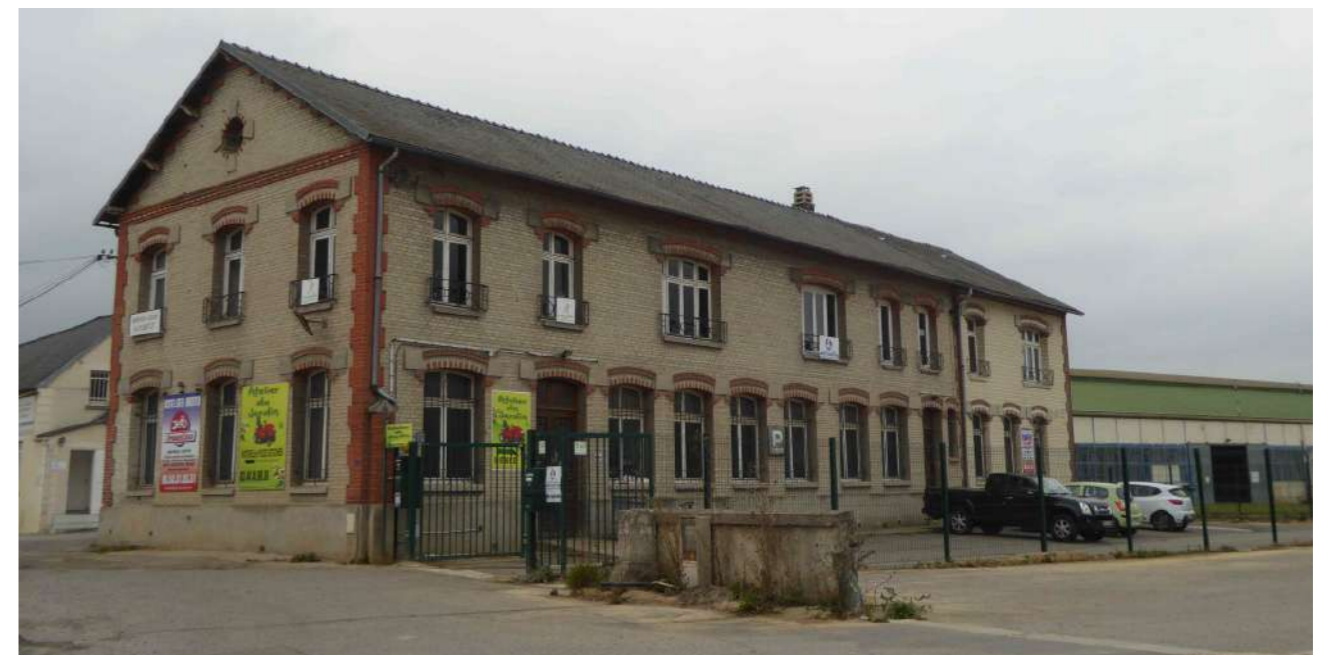
Bâtiment d'usine ancien en briques silico-calcaires avec modénature en brique rouge
