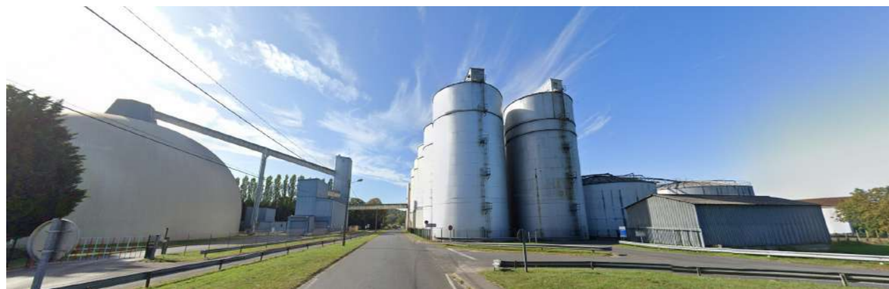
Vue sur la zone d'activités depuis le bourg, rue Marcel Rinn
