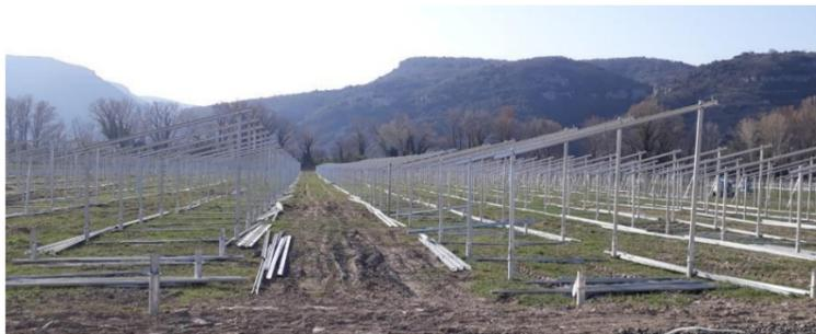
Exemple de structures et fondations par pieux en acier
