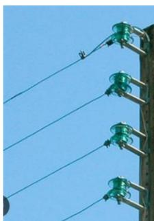
Dans une bonne partie de notre commune, la distribution électrique est réalisée par 4 fils que nous pouvons apercevoir en partie haute des poteaux. Ces fils sont arrivés à un stade d'usure très important. Afin d'éviter des problèmes de panne ou de coupure, ENGIE procède au remplacement de ces éléments par un seul câble torsadé basse tension.
